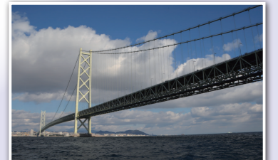
明石海峡大橋
